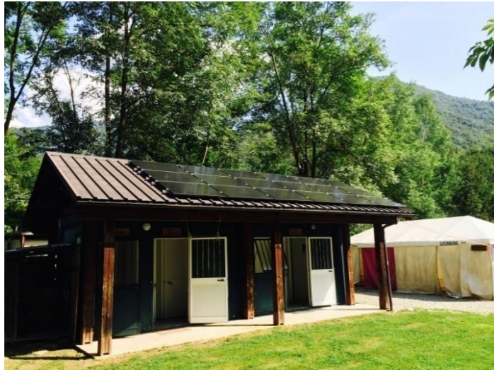
Realizzazione impianto FV da 2,97 kWp con CU-Q LP per una produzione di 4000 kWh/anno
